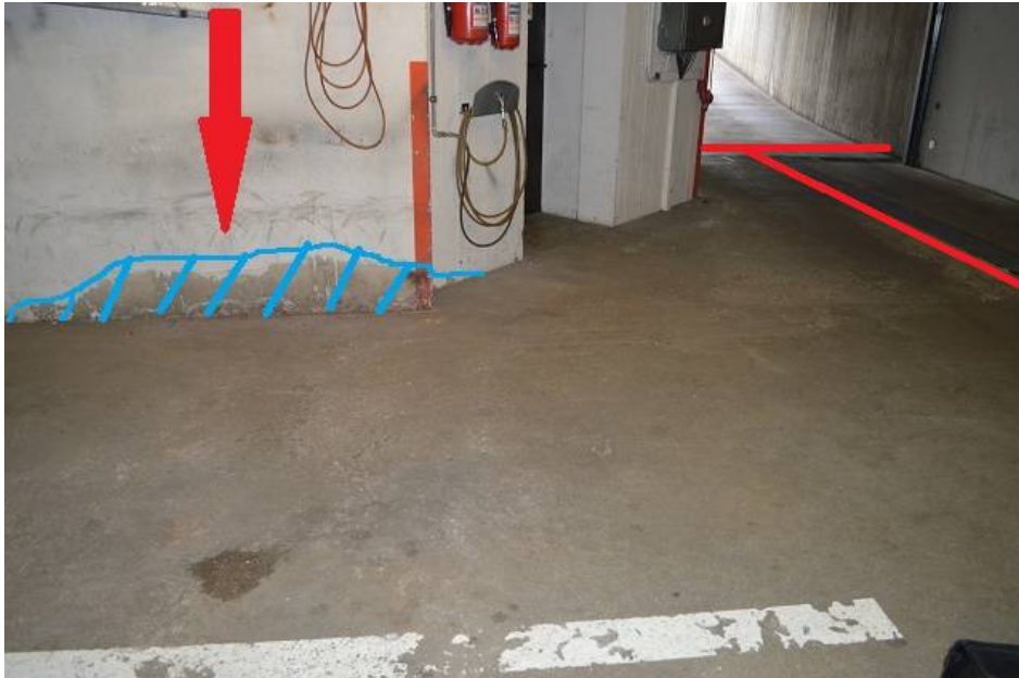
05) Kapillar aufsteigende Nässe im Mauerbereich unmittelbar links und seitlich des Einfahrtbereich.
