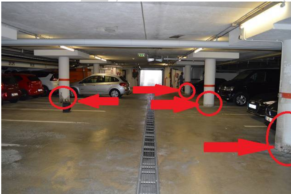
06) Weiter greift die kapillare Feuchtigkeit wie hier im Bild dargestellt auf die tragenden Stützsäulen über -diese werden durch einen schleichenden Prozess fortlaufend geschwächt.
