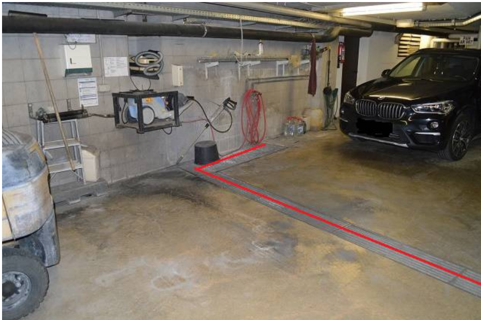
03) Verlauf der Entwässerungsrinne bis zum Waschplatz
